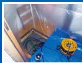
① 床下収納庫から、もしくは畳を1~2枚上げて床下に入ります。(丁寧に養生いたします)
