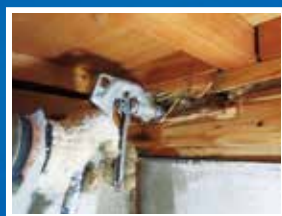
③ 風呂場、トイレ、玄関などのコンクリート部分や被害箇所には必要に応じ穿孔薬剤を注入します。
