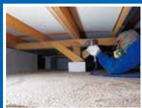
② 土壌、基礎をチェック。白蟻の発生しやすいところを薬剤処理します。
