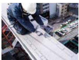
鳩飛来防止工事
